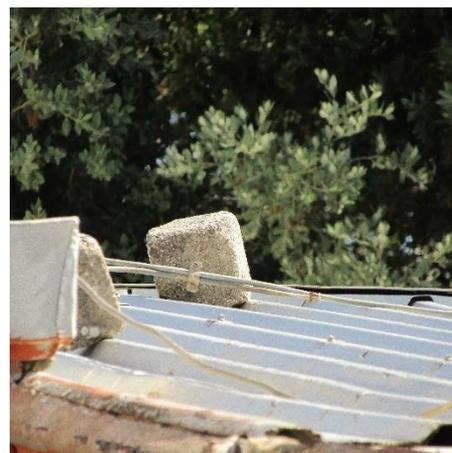
I canali di gronda ed i pluviali in lamiera sono praticamente inesistenti e fonte di gravi situazioni di pericolo per l'incolumità dei bambini e del personale scolastico
