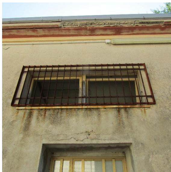
E' evidente che occorre intervenire immediatamente con il ripristino di intonaci, riparazione di cornicioni e rifacimento del rivestimento murale con pitture idonee per evitare ulteriori azioni che comprometterebbero, irrimediabilmente, anche gli ambienti interni.
