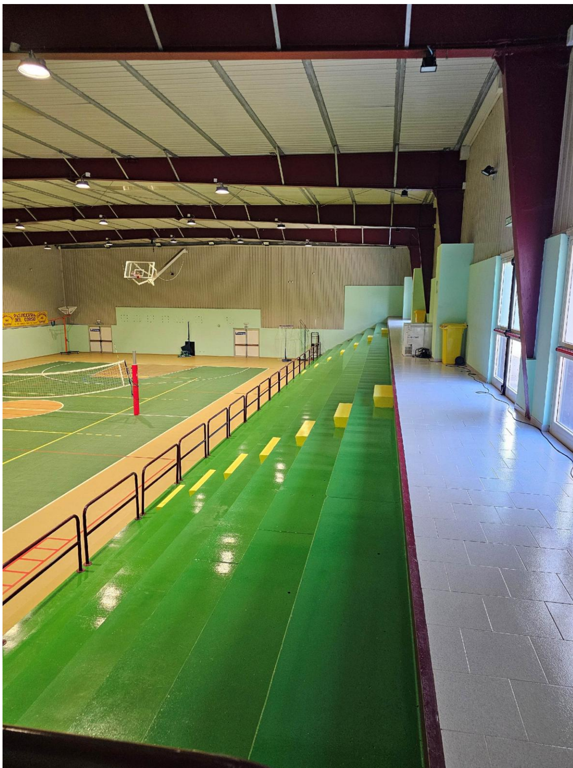
Foto 28 - campo da gioco e gradoni vista piano primo
