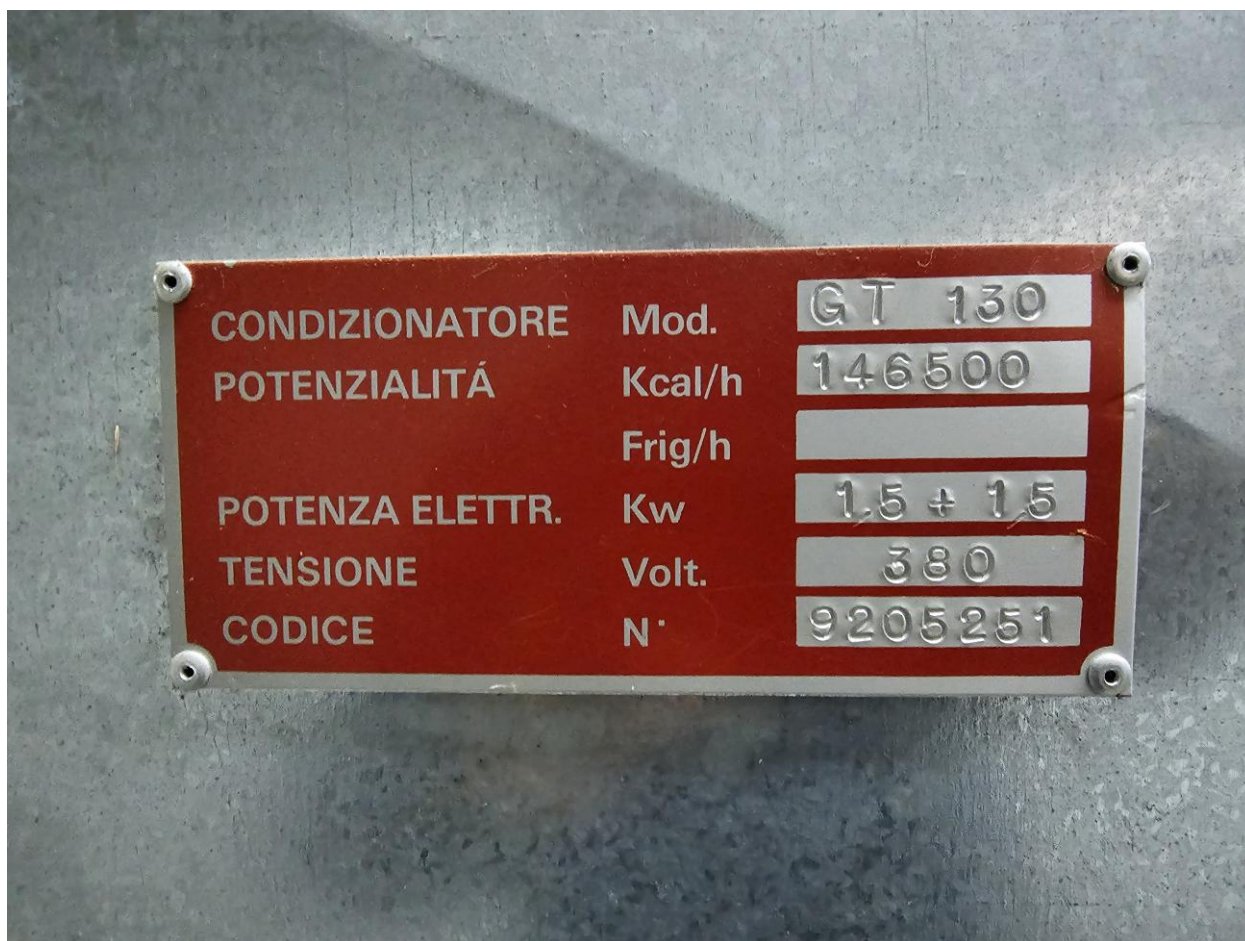
Foto 19 - vista interna: targa UTA sotto gradinata
