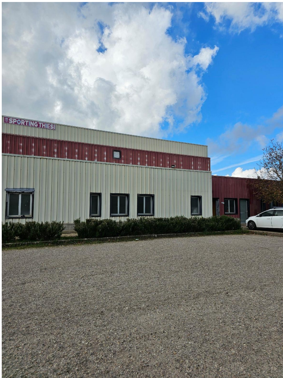
Foto 3 - vista prospetto C (lato destro)
