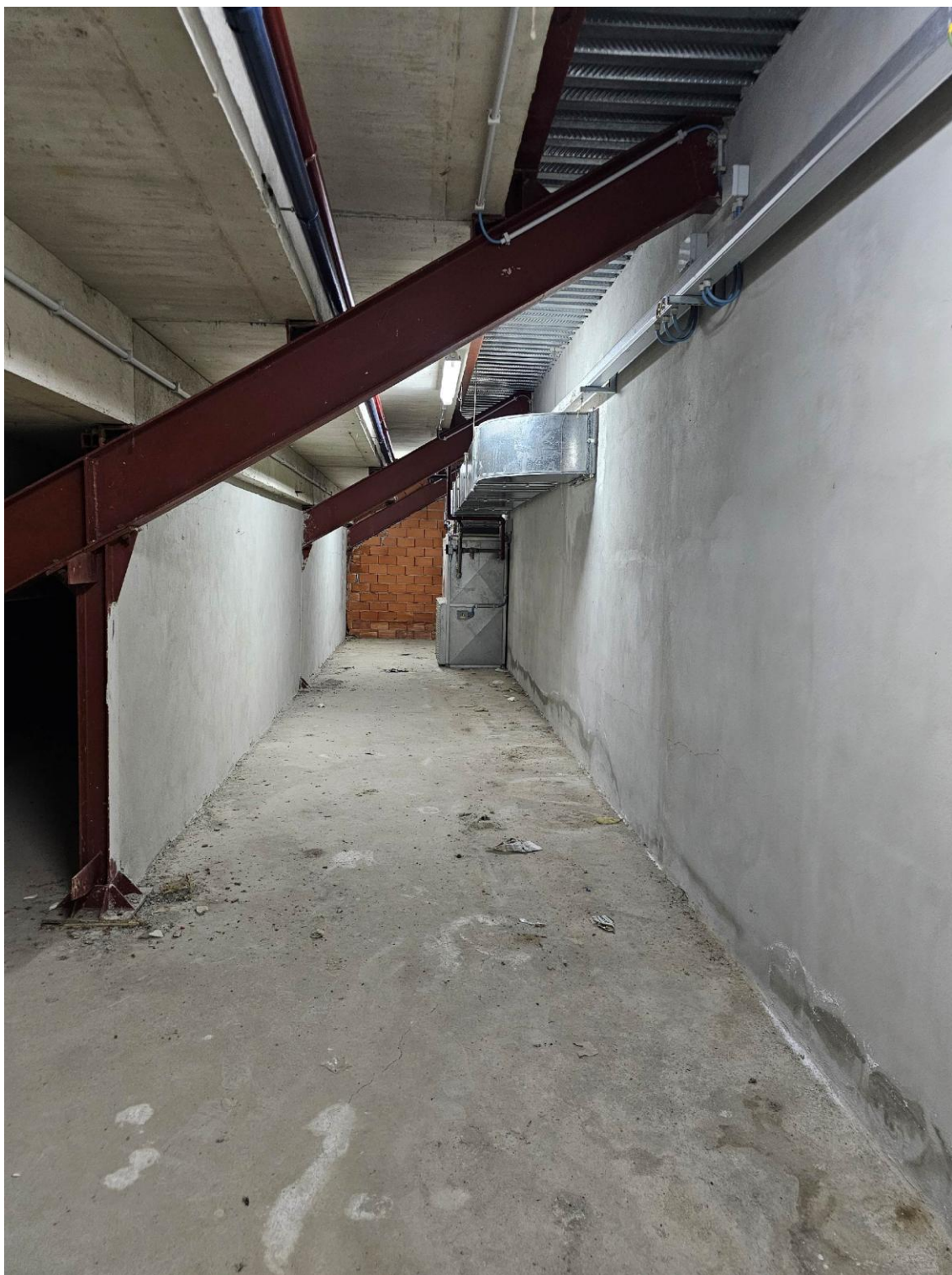
Foto 20 - vista interna: sotto gradinata
