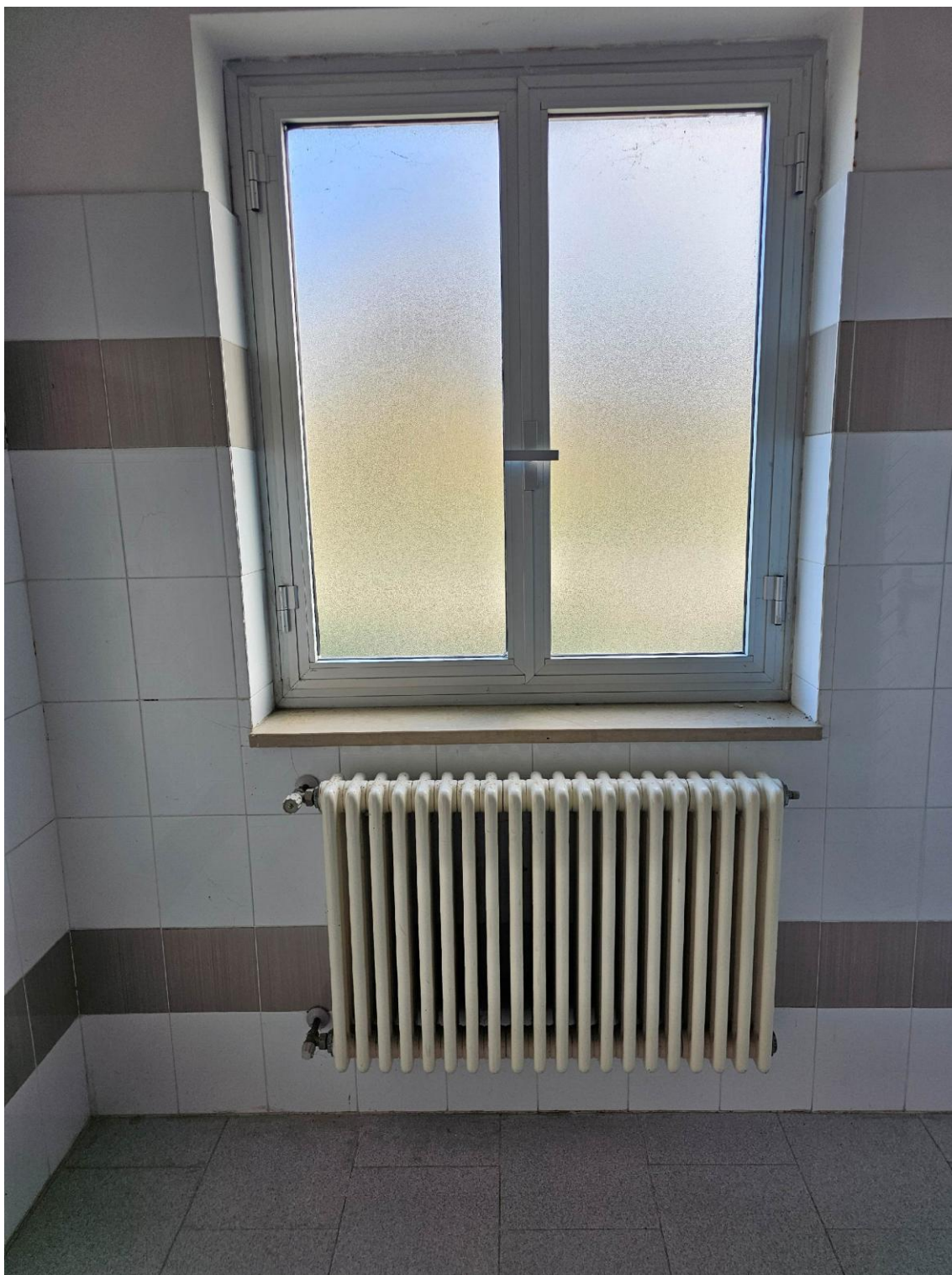
Foto 10 - vista interna: infisso tipo e radiatore tipo
