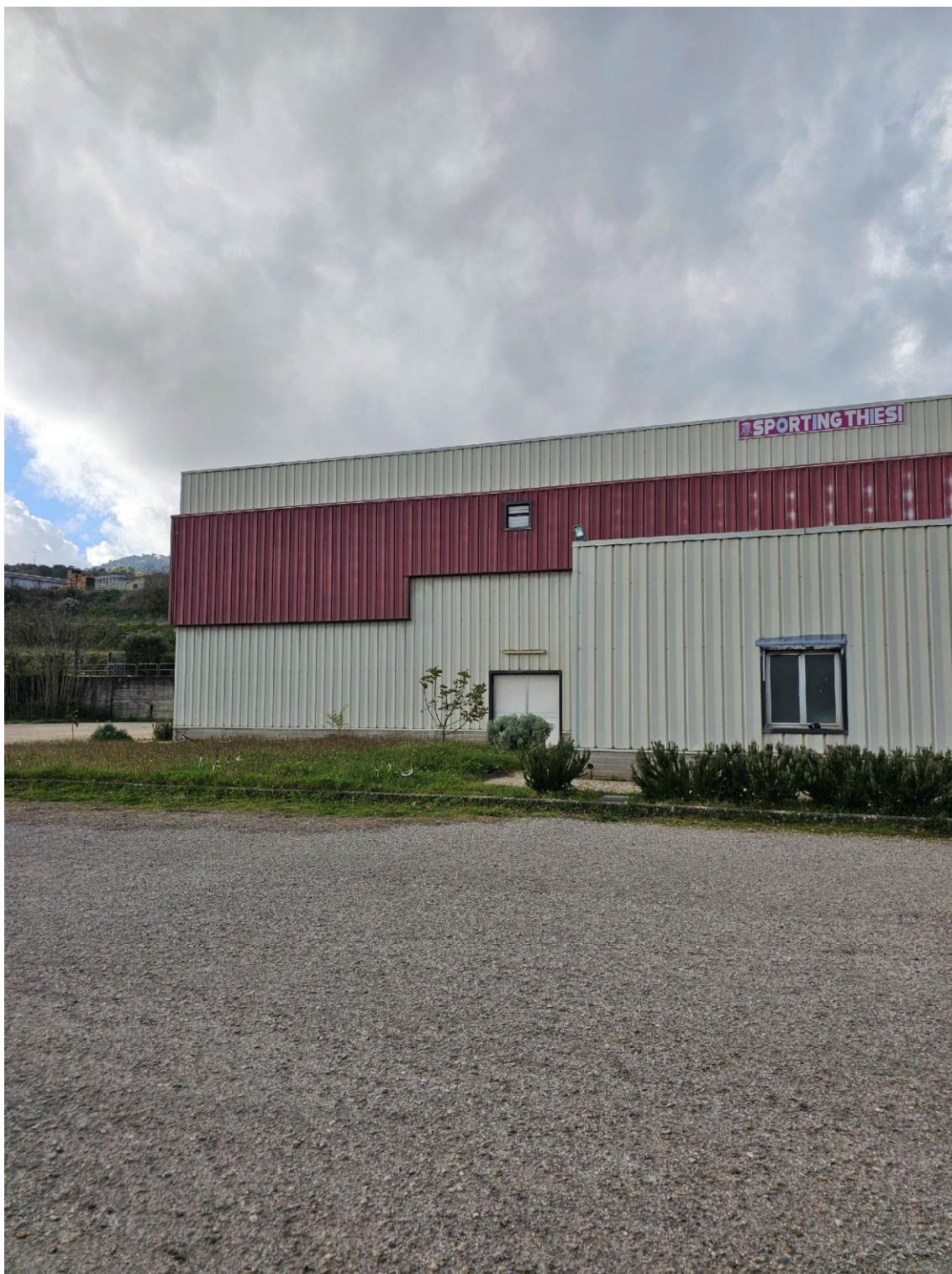
Foto 2 – vista prospetto C (lato sinistro)
