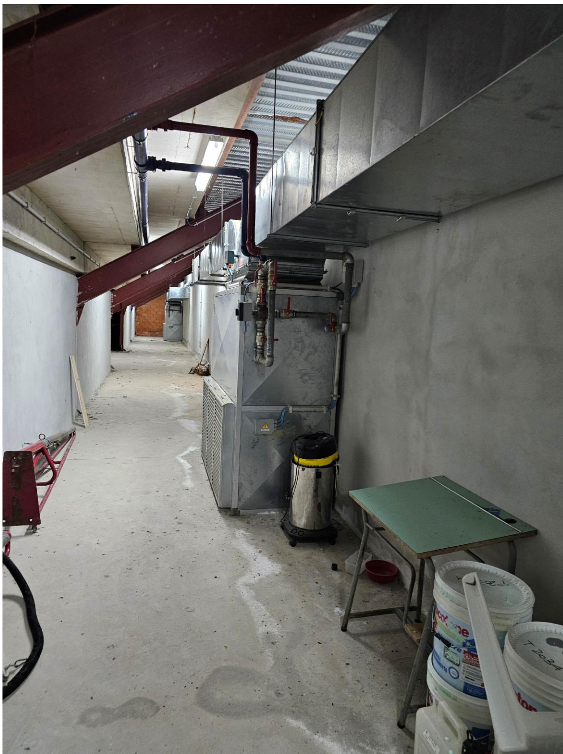
Foto 18 - vista interna: sotto gradinata
