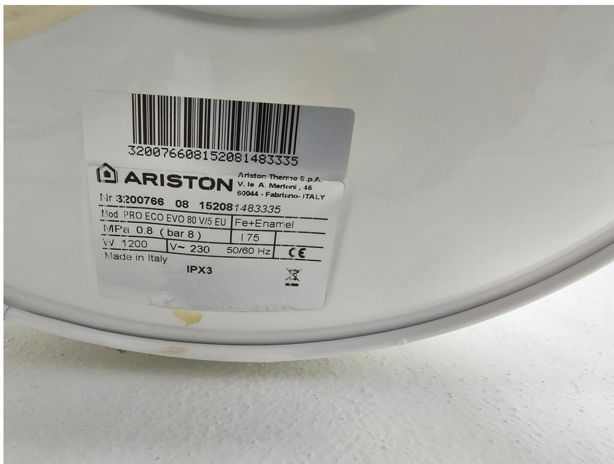
Foto 17 - vista interna: scaldabagno puntuale
